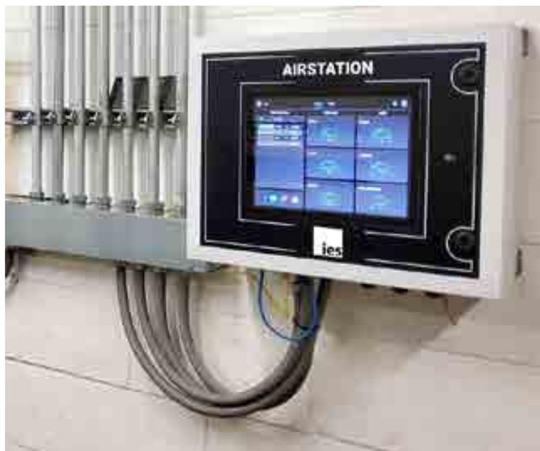
**AIRSTATION** è il cervello che viene installato localmente e connesso digitalmente tramite il cloud o LAN.
